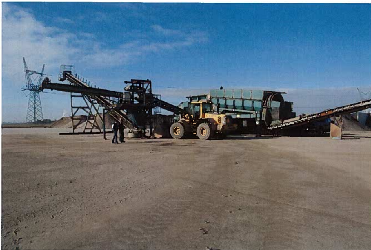
Billedet vier slaggesorteringsanlægget på pladsen i Aalborg
