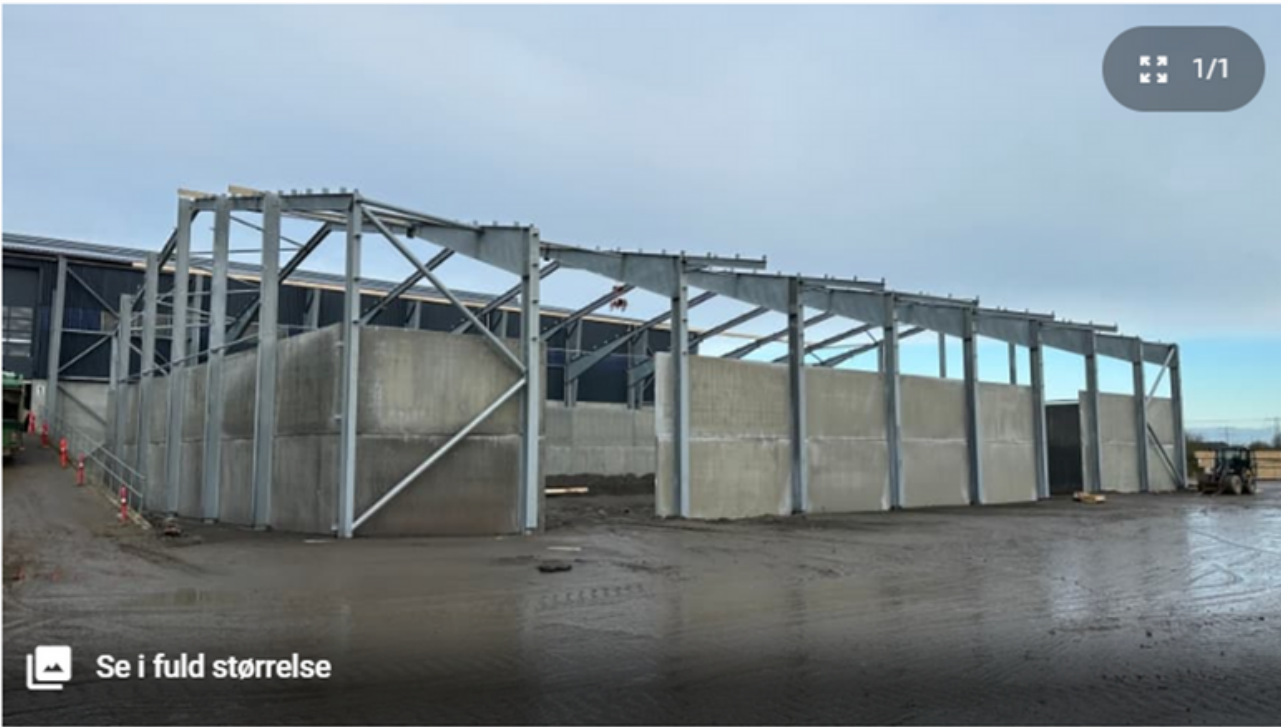
Meldgaard er lige nu ved at opføre en hal til den store ballepresser. Foto: Meldgaard
